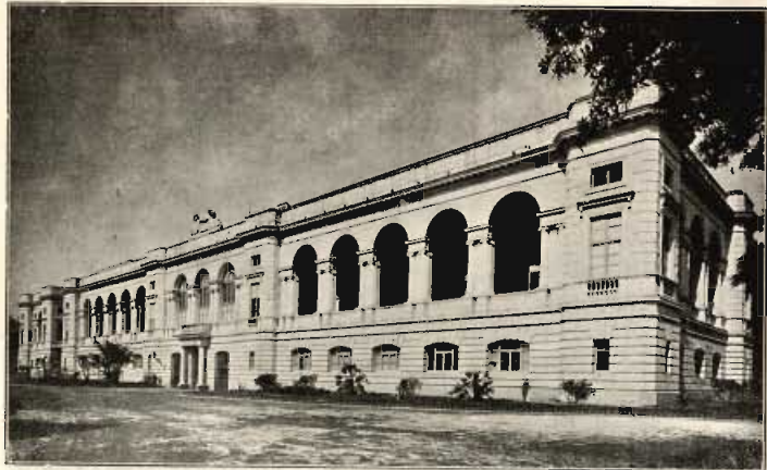
Fig. 2. — La facciata verso il mare.
